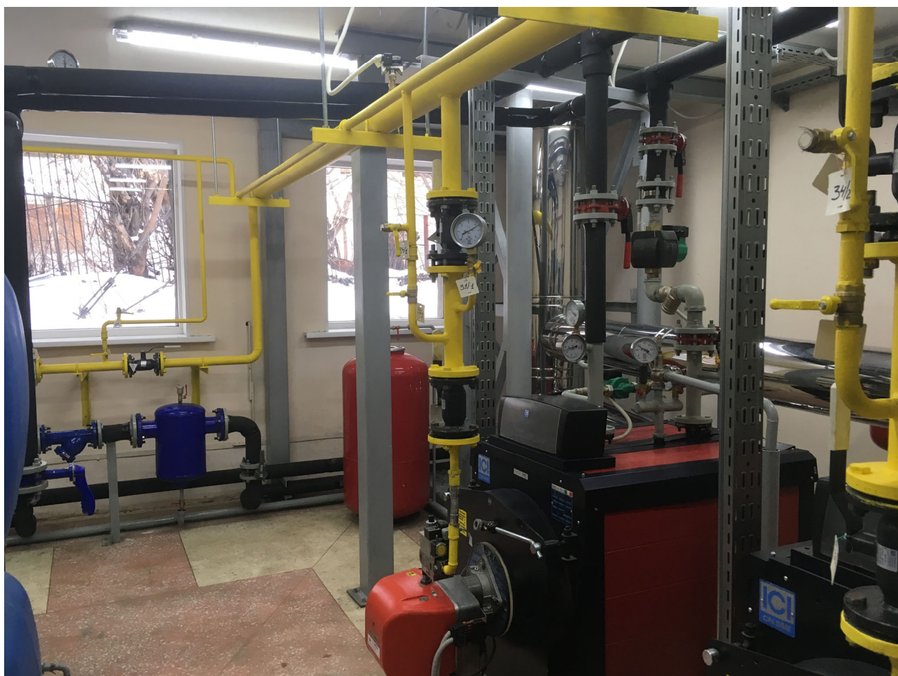
Новая газовая котельная 2017 г
